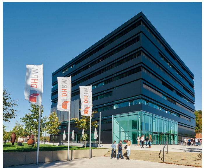
Veranstaltungsort des Fachtags 2018: DHBW Heidenheim, Gebäude Marienstraße.
