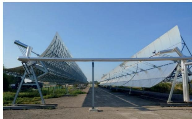
Abb. 1: Solare Prozesswärmanlage in Oostende, Belgien (Dampfbereitstellung bei 11 bar/180 °C bei einer Leistung von 600 kWth). Quelle: Solarlite CSP Technology GmbH
